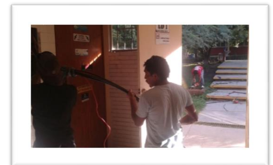
Imagen 40. Reparación de cableado para el laboratorio de Botánica
