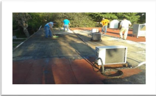
Imagen 45. Impermeabilización de Aulas, Oficinas y Laboratorios
