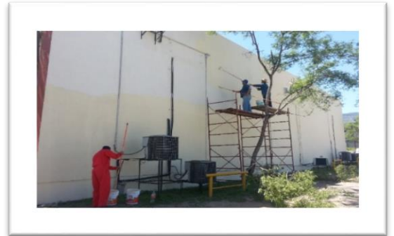
Imagen 46. Impermeabilización de Aulas, Oficinas y Laboratorios
