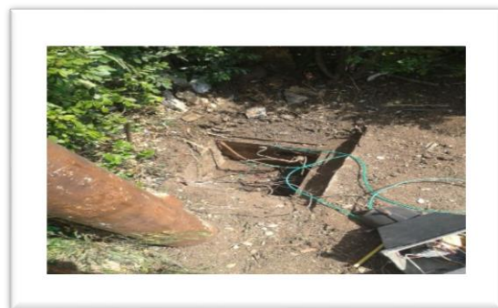
Imagen 39. Mantenimiento a la red eléctrica del estacionamiento de Electrónica
