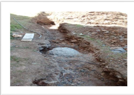
Imagen 47. Reparación de fuga en circuito interior
