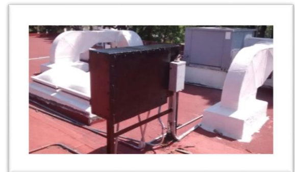
Imagen 42. Impermeabilización de Aulas, Oficinas y Laboratorios
