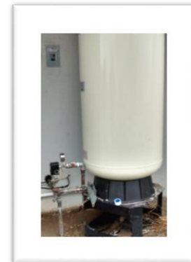
Imagen 48. Compra e instalación de hidroneumático para laboratorios de Ing. en Sistemas e Ing. Industrial
