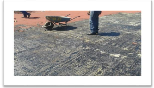
Imagen 44. Impermeabilización de Aulas, Oficinas y Laboratorios
