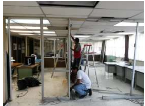
Mantenimiento de Oficinas
