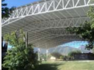
Construcción de la techumbre
