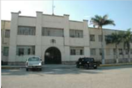
2.- Centro de Ejecución de Sanciones de Victoria, Tam.
