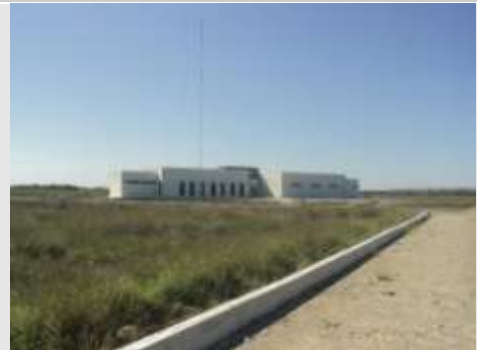
Unidad Académica Abasolo (en construcción)
