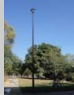
Instalación de equipos eléctrico de alumbrado.
