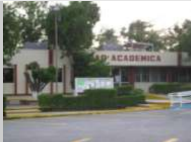
Pintado de Edificio de Unidad Académica
