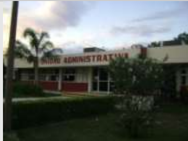
Pintado de Edificio Administrativo
