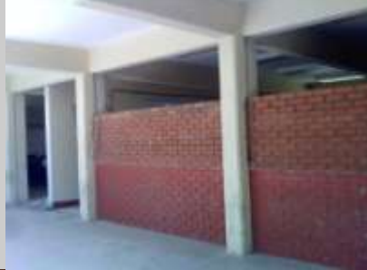
Remodelación de Aulas Inteligentes
