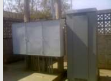
Mantenimiento de Subestación Eléctrica
